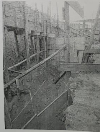
Foto 4 – Armação forma e escoramento da viga inclinada com a armação de engaste para o balanço posicionadas
